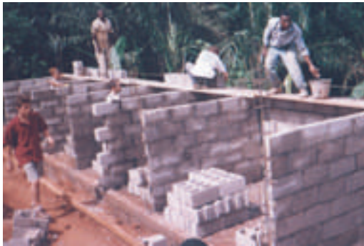
construction au Cameroun
